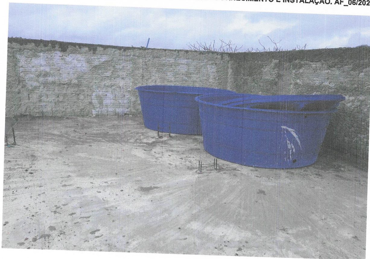
FOTO 16 - CAIXA D'ÁGUA EM POLIETILENO, 2000 LITROS - FORNECIMENTO E INSTALAÇÃO. AF_06/2021
